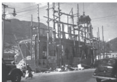
Demolición del Teatro Bartolomé de Medina, 1943.
