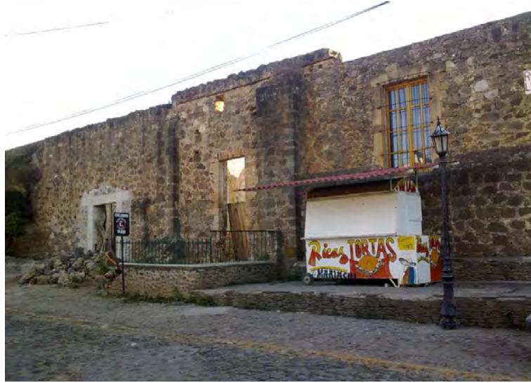
Vista lateral del ex convento donde se aprecia el derribo parcial para hacer locales comerciales.
