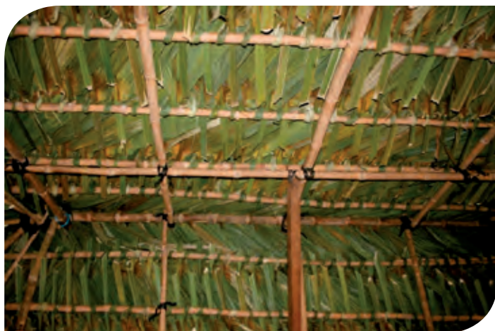
Figura 18. Techo finalizado de la palapa.
