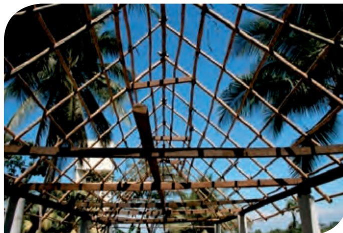
Figura 12. Esqueleto del techo terminado, con varillas, ‘carga zacates’ y caballetes colocados.
