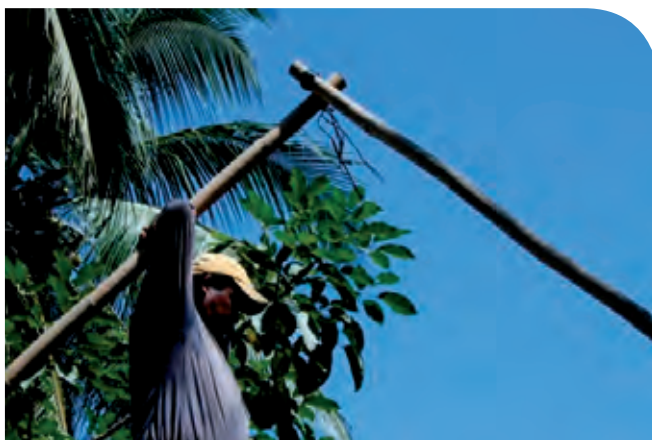
Figura 8. Corte preciso al palo de otate y amarrede éstos para formar el esqueleto.
