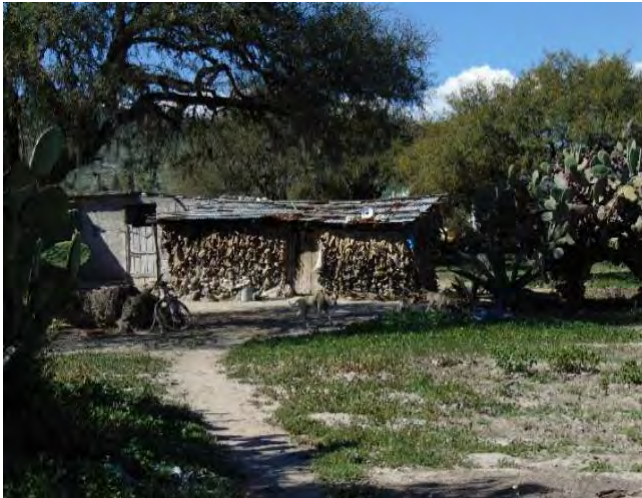
Figura 10. Construcción de jacal con pencas de maguey, San Andrés Daboxtha, noviembre de 2015 (fotografía del autor).
