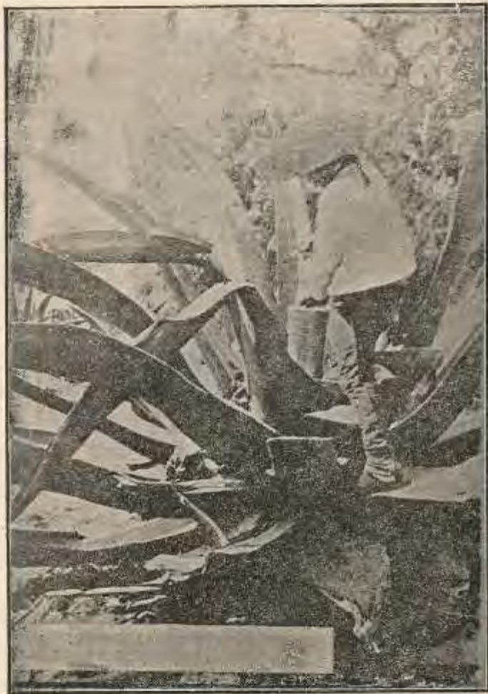
Figura No. 28.—Extrayendo aguamiel con la bomba "Tepa". La operación es más sencilla, cómoda y rápida que con el antihigiénico e incómodo acocote.
